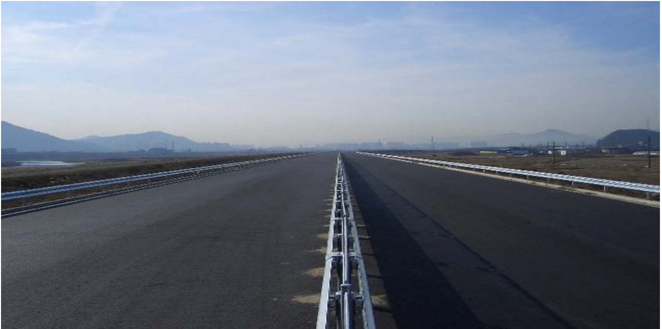
< 안강~청령간 도로 확·포장 공사구간 >
